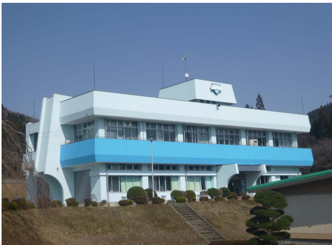
山館浄水場管理棟
